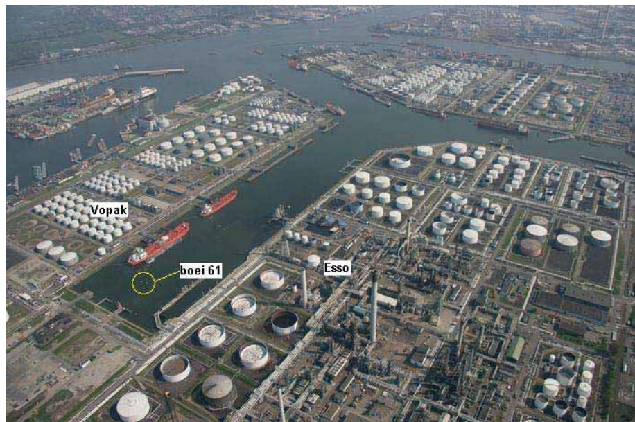
Afb. 1: Explosielocatie 3e Petroleumhaven Rotterdam
